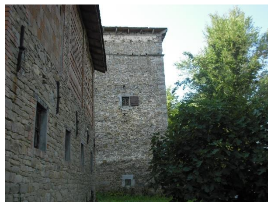
Casa a torre (Palagano)
