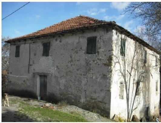
Prignano, edificio a pianta regolare con due piani per residenza e piano seminterrato per servizi
