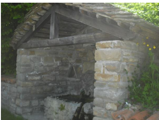
Fontana lavatoio, Palagano.
