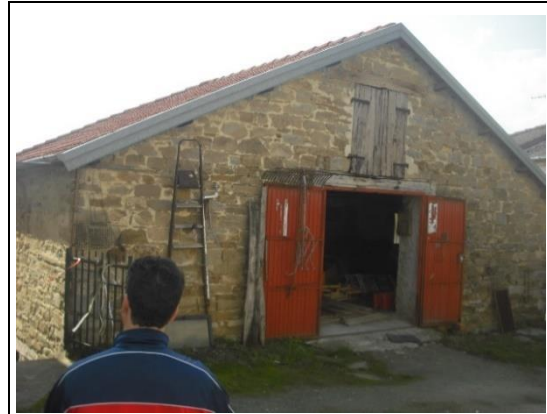
Montefiorino, edificio di servizio a capanna, con accesso ai piani di campagna da due distinti livelli.
